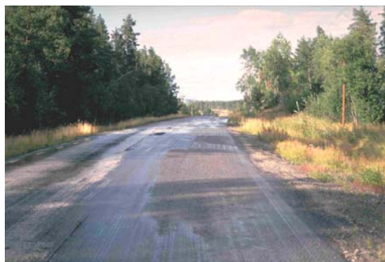
Planfräst AEB Ö ”i dagen” norr om Oringen. Nu är ytan ytbehandlad.
